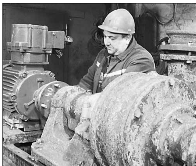
Слесарь-ремонтник А.С. Хрипка выполняет ремонт шламового насоса 6Ш8/2.
